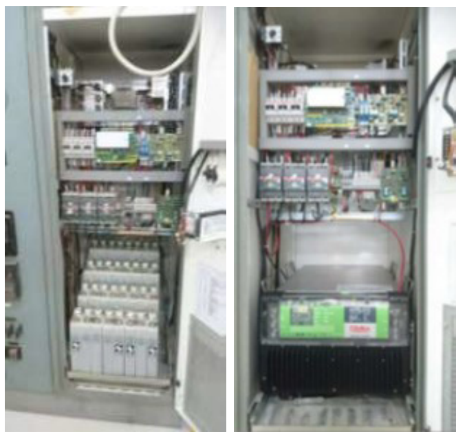
Sala de baterías original con batería VRLA
